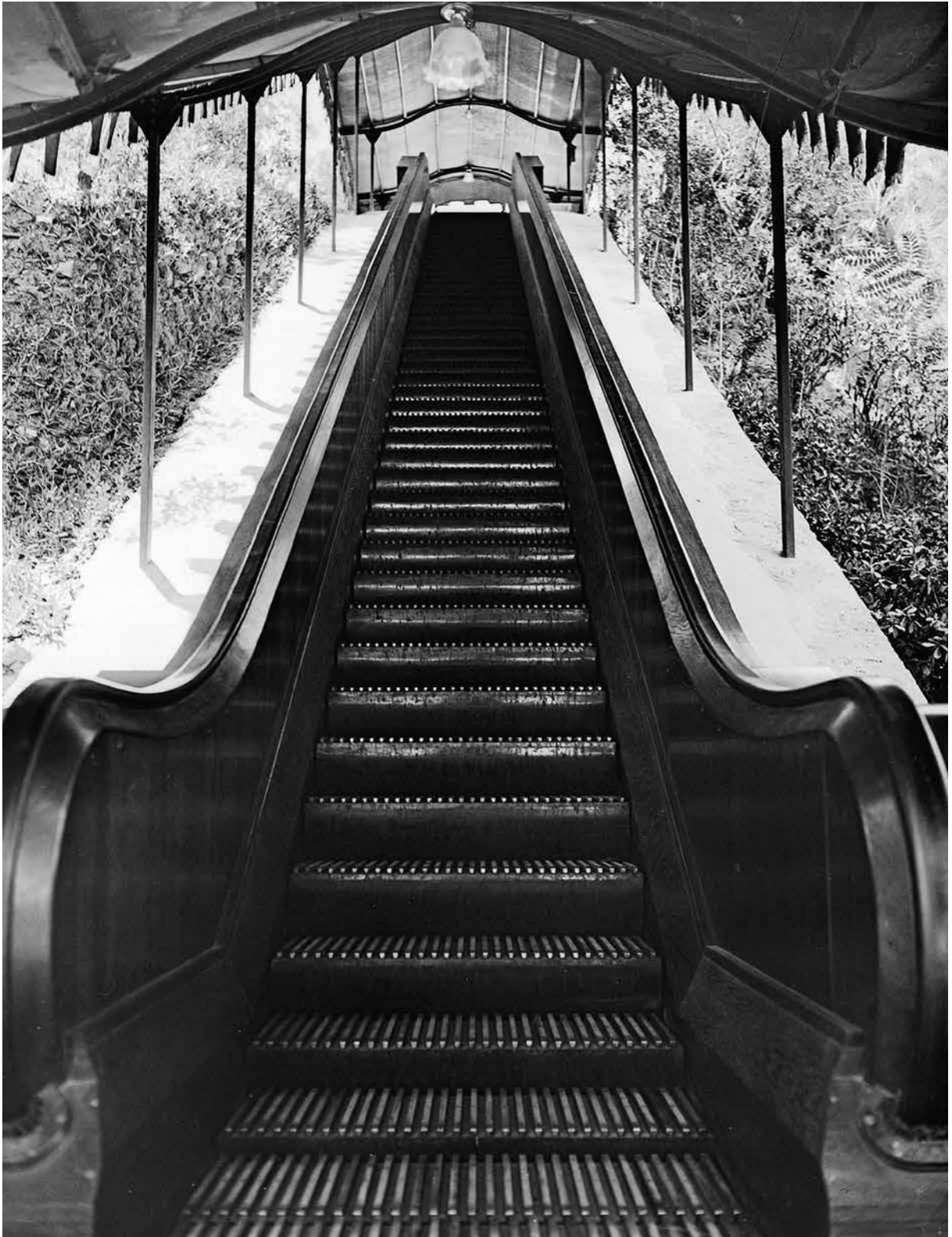
Accés a les instal·lacions de Monjuïc.
